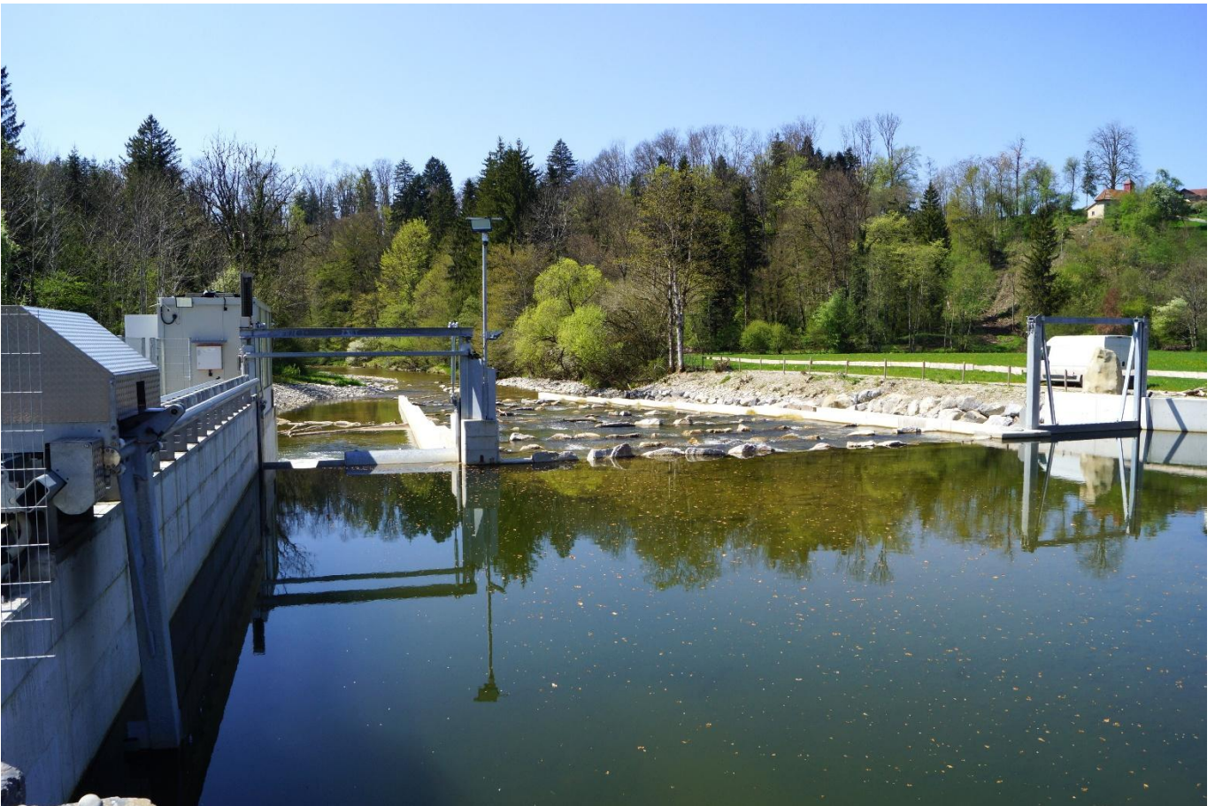
Wasserkraftanlage Schomburg an der unteren Argen; Bild: AWK BW
