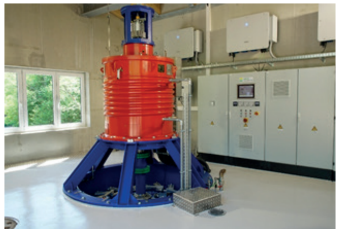
Kaplanturbine WKA Schomburg, Bild: D-Energy GmbH & Co. KG
