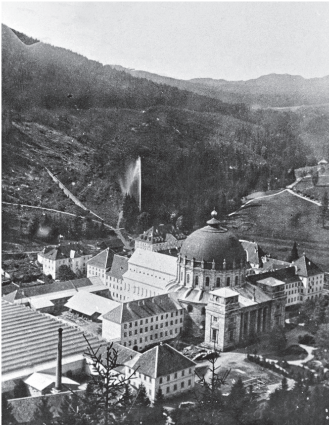
Nach einer Brandkatastrophe im Jahre 1874 wurde die Spinnerei St. Blasien in einem separaten Gebäude neu aufgebaut (links unten). Auch die rund 40 m in die Höhe schießende Fontäne ist das Ergebnis wasserbau-licher Ingenieurskunst (hinten), Bild: Slg. Lothar Lüber
