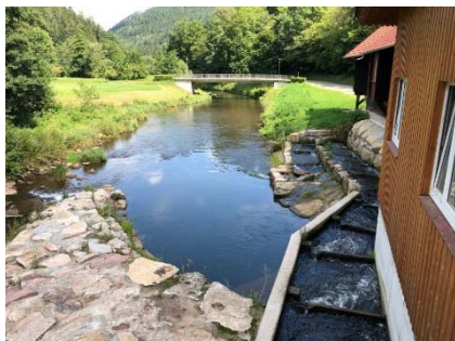
Kleine Wasserkraftanlage im Schwarzwald. Foto: Neff
