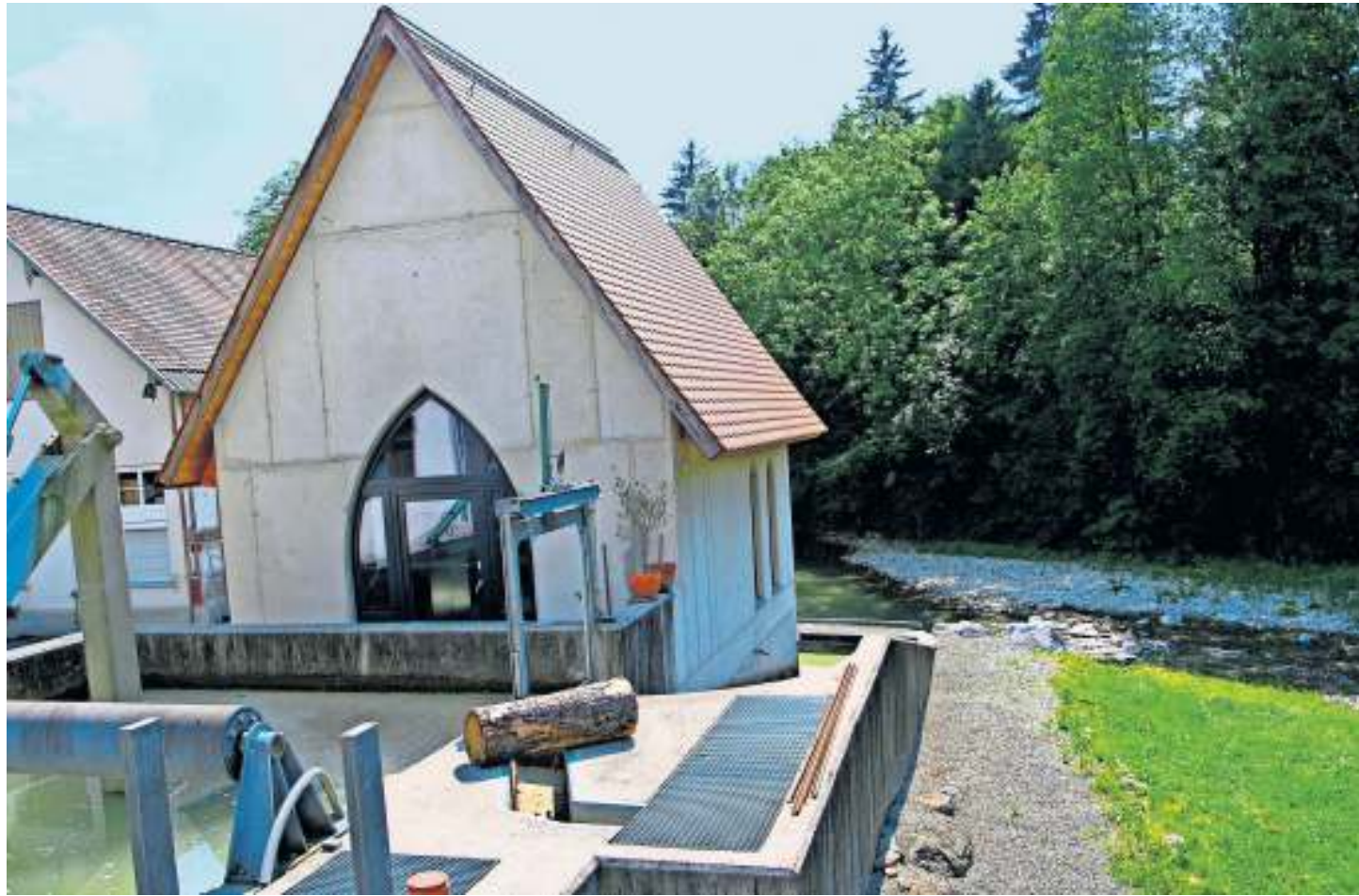
In Wangen-Beutelsau steht ein modernes Turbinenhaus zur Stromerzeugung. Ein „Fischpass“ (unten links) sichert die Fischwanderung.
