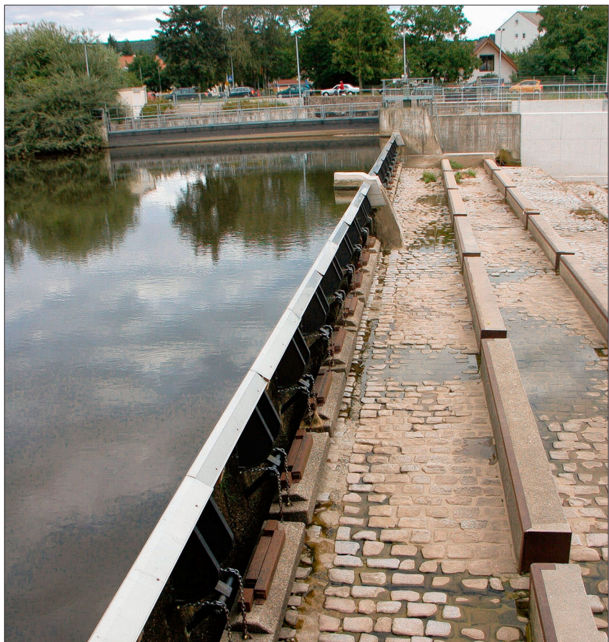
Tumringer Wehr: Beim derzeitigen Wasserstand der Wiese liegen die Wehrtreppen trocken.
