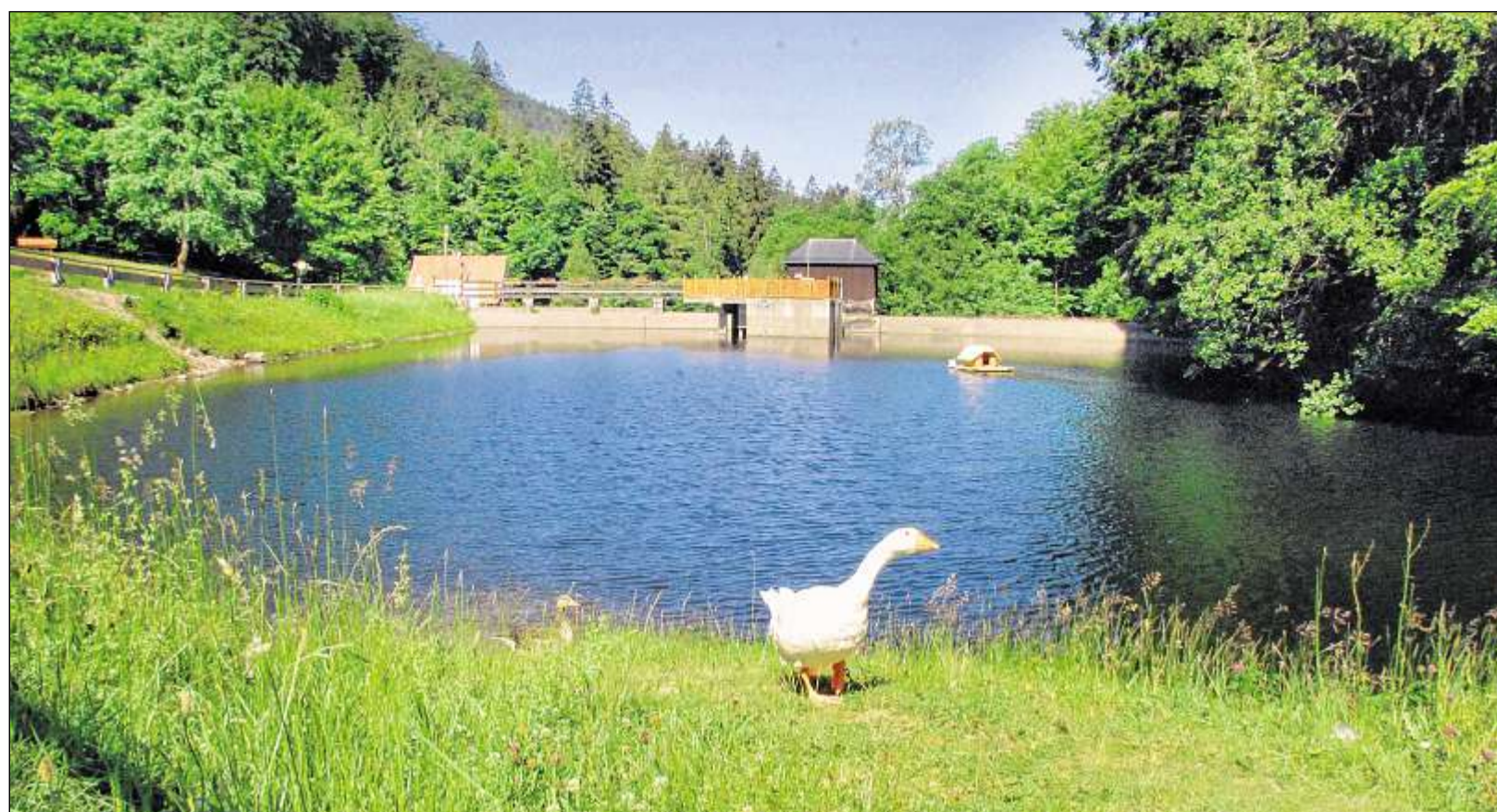
IM IDYLLISCHEN LAUFBACHTAL befindet sich der Stausee im kleinen Weiler Glashütte. Er funktioniert wie ein Energiepuffer, denn er speichert insgesamt 5 500 Kubikmeter Wasser. Das gesamte Wasserkraftwerk wurde bereits 1923 erbaut. Foto: Margull
